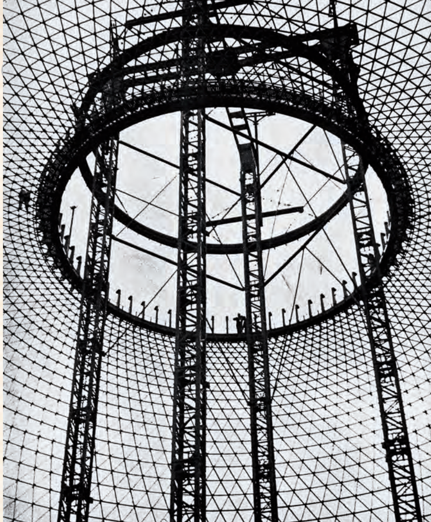
M. Budík: Zvedání kopule pavilonu Z na brněnském výstavišti
