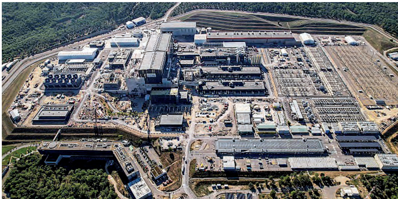
Obří staveniště ITER v září 2023
