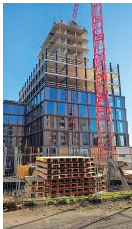
Z výstavby: Timber Peak, Mainz Zollhafen
