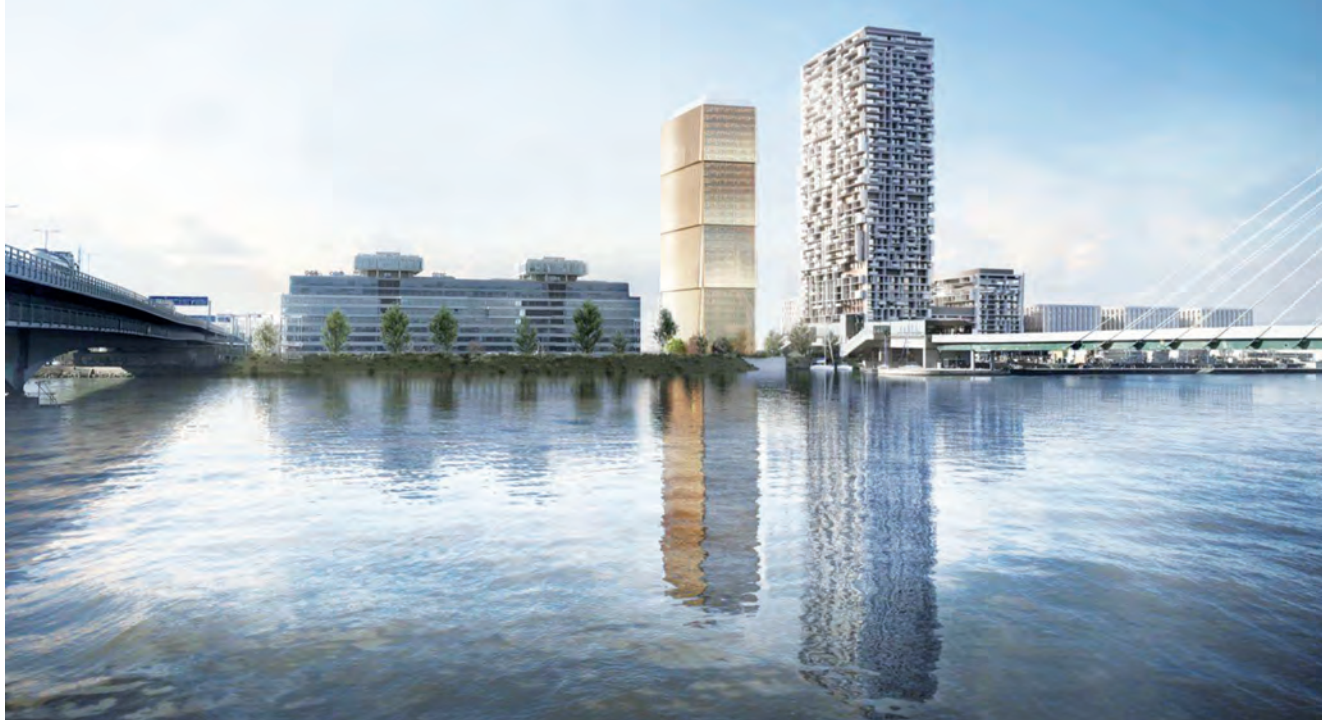
V přípravě: Donaumarina Tower, Vídeň. Výška 113 metrů, hybridní dřevěná konstrukce, 32 NP, 4 PP, HPP: 44 000 m 2
