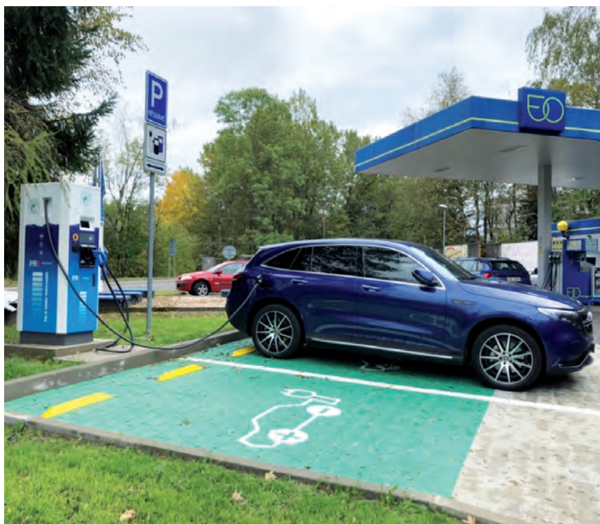
Dobíjecí stanice na čerpacích stanicích EuroOil v Jablonci nad Nisou
