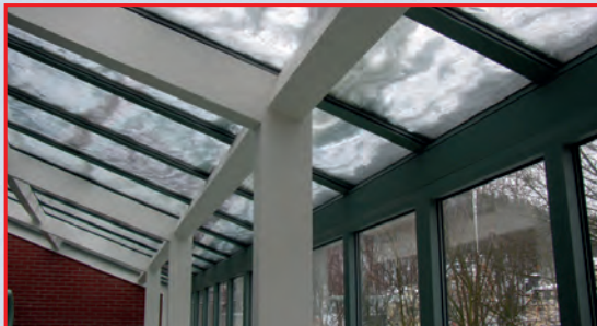
Obklad ocelových konstrukcí
