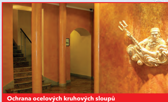
Ochrana ocelových kruhových sloupů
