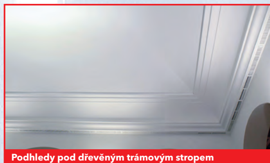
Podhledy pod dřevěným trémovým stropem
