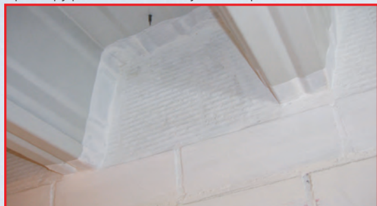
Utěsnění stavební spáry
