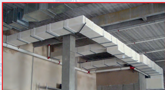
Vzduchotechnické potrubí
