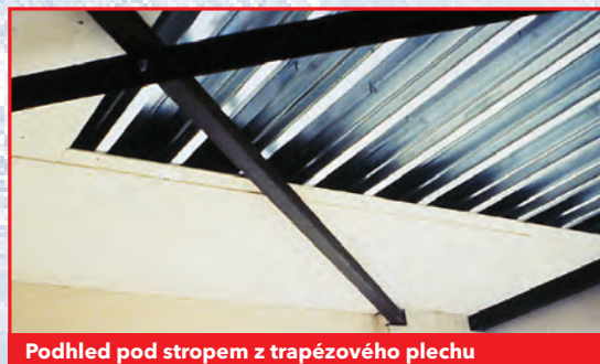
Podhled pod stropem z trapézového plechu
