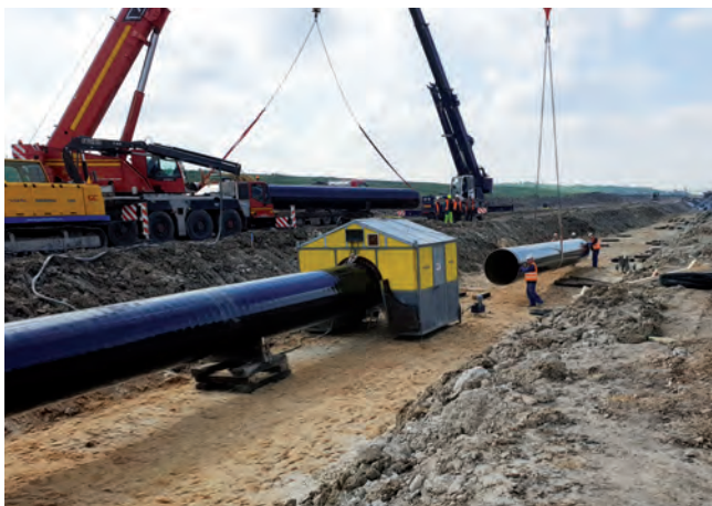
Práce na přeložce sítí v Hořanském koridoru na Mostecku
