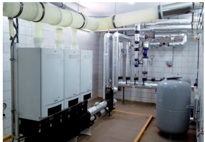
Rekonstrukce plynové kotelný v Opavě
