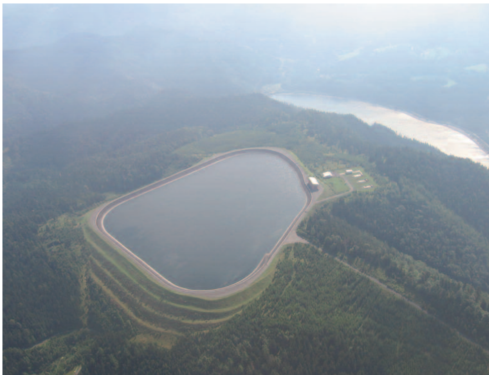
Přečerpávací vodní elektrárna Černý Váh je údolní přehradní nádrž v Liptově na Slovensku, která byla vybudovaná na středním toku Černého Váhu v nadmořské výšce 733 m. Elektrárna byla uvedena do provozu v roce 1981. Nádrž má objem 3,7 mil. m 3 vody. Vodní dílo se skládá ze dvou nádrží, přičemž horní nádrž byla vybudována na krasové plošině Vyšné Sokoly v nadmořské výšce 1160 m.
